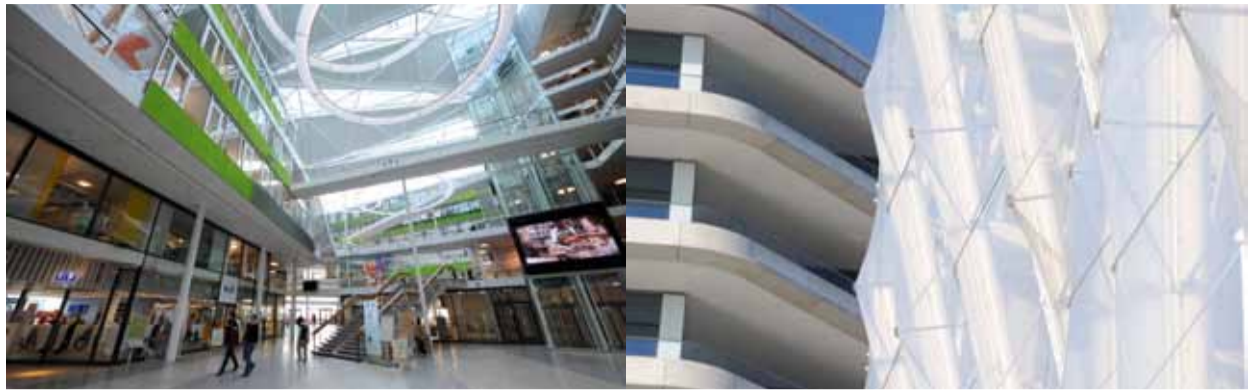
Innovativ und nachhaltig: die Unilever-Zentrale am Strandkai mit öffentlichem Atrium und windabweisender, transparenter Membran-Fassade
